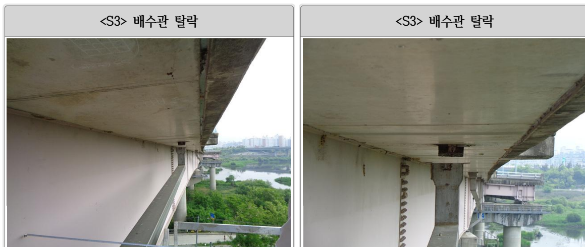
<표 3.3.3> 배수시설 손상물량표
