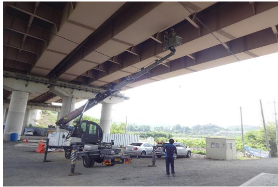
고소점검차를 이용한 점검
